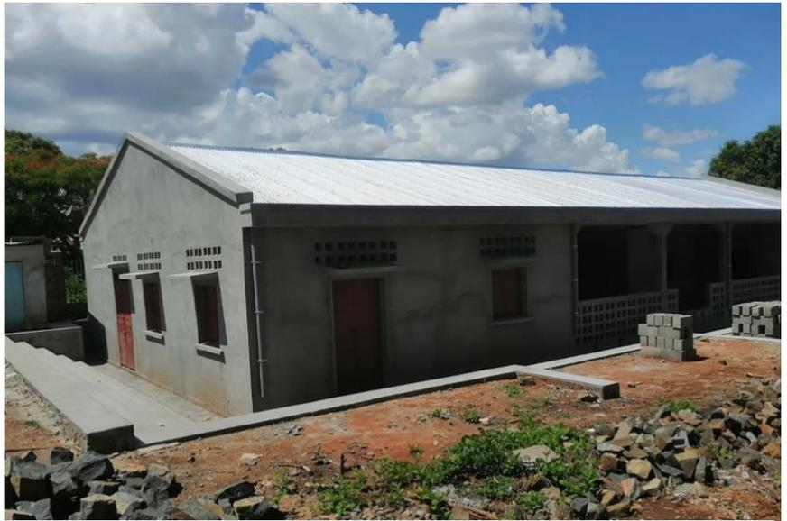
*Le toit est fait d'une seule pièce de tôle galvanisée, pour en garantir l'étanchéité*
